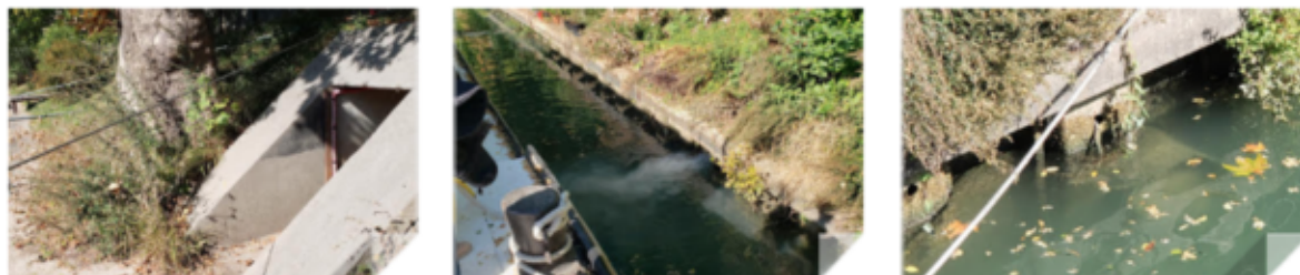
Figure 2: Rejets identifiés sur le périmètre potentiel de l'étude : un rejet potentiel inactif (gauche), un deuxième très actif (Rejet A, au centre, périodicité toutes les 10 minutes) et un troisième actif uniquement en cas de grosses pluies (Rejet B, à droite, périodicité trimestrielle)
